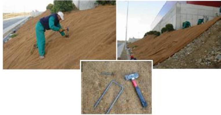
Figura VI.14 Malla orgánica, materiales necesarios para su colocación.
