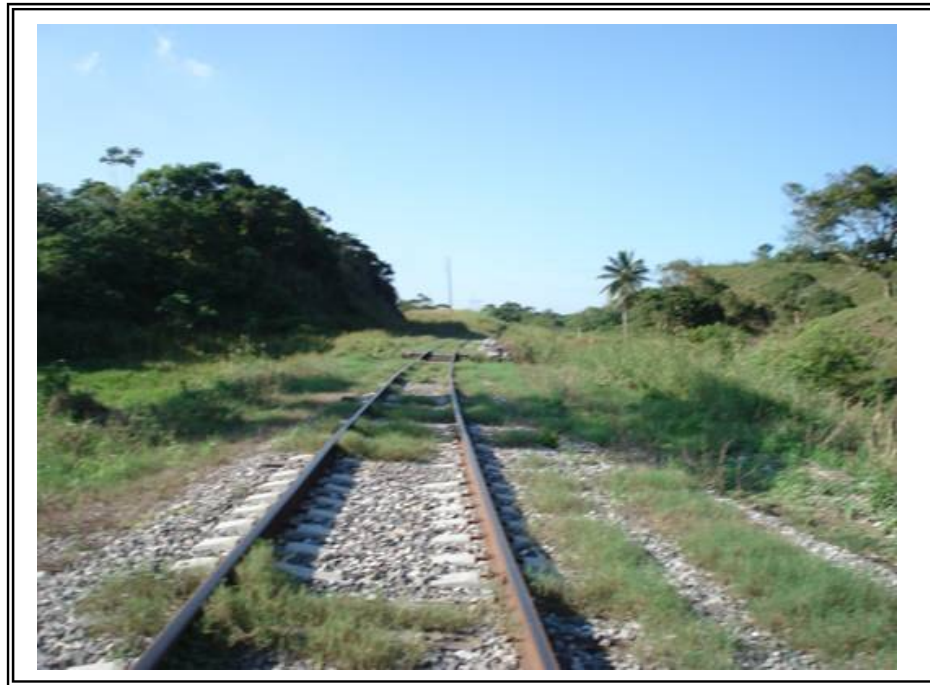
MF-15: Cruce del Salinoducto con vías de ferrocarril en el KM-6+252.213.
