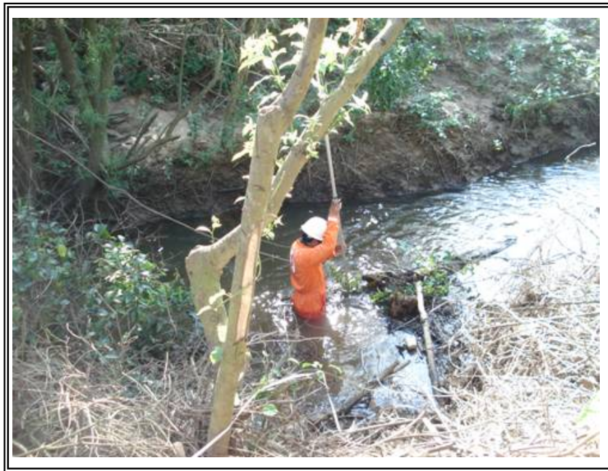
MF-14: Cruzamiento del Salinoducto en Arroyo Tepeyac en el Km 6+017.00 en la imagen se puede observar al personal detallando cruzamiento.
