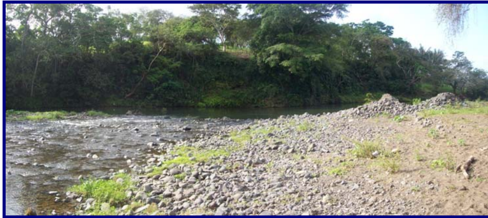
FOTO 3. LIMITE DEL NIVEL DE AGUAS MÁXIMO ORDINARIO DEL RÍO
