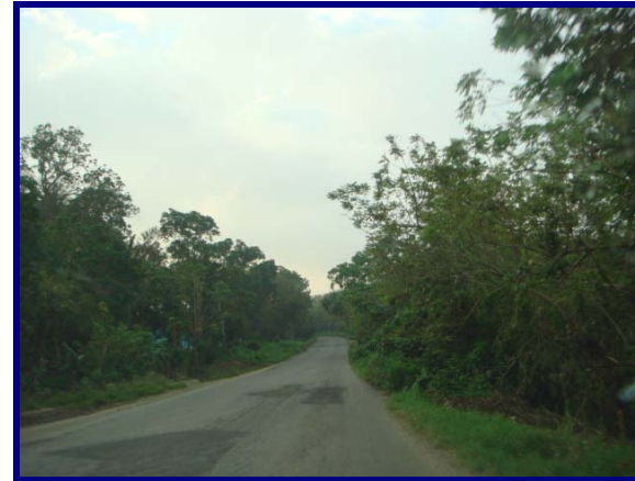
FOTO 10. CARRETERA NO. 145 DIRECCIÓN A SANTIAGO TUXTLA
