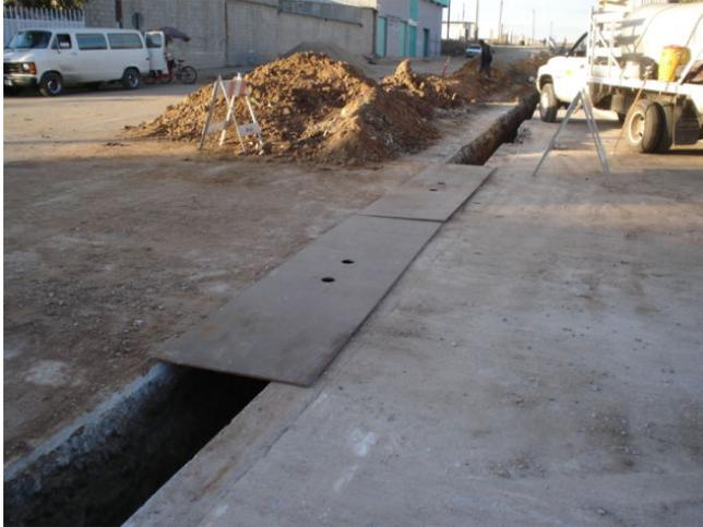
En caso de requerir tener abierta la zanja por una tiempo mayor a lo programado, se instalarán placas de acero en aquellos lugares que así se requiera para el paso de vehículos.
