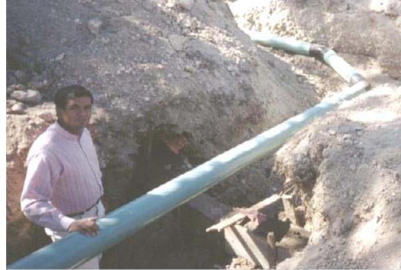
Toda la **tubería de acero** requiere protección contra la corrosión, por lo que requiere protección mecánica y protección catódica. En el caso de la tubería aérea de las casetas de medición y regulación se protegerá con un primario y acabado adecuados para el ambiente de la zona. Las casetas son prefabricadas y serán pintadas en la planta del fabricante.
