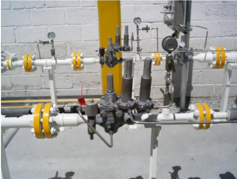
Los reguladores de presión deberán mantener la presión esperada a la salida de ellos. La caída de presión máxima a través de un regulador de presión no excederá las recomendaciones del fabricante.
