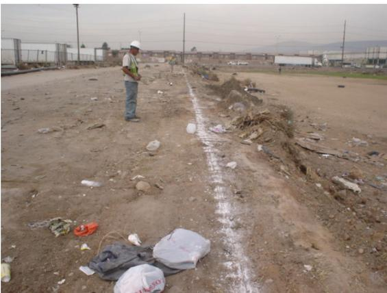
En zonas urbanas, se traza el eje del ducto con pintura sobre el asfalto.
