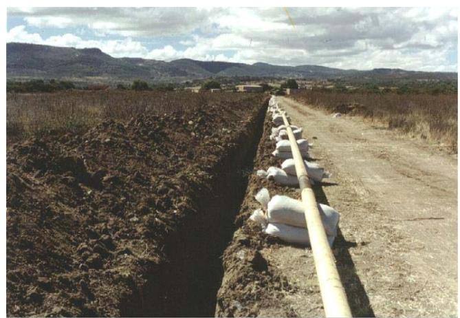
Cuando se descargue tubo sobre el Derecho de Vía (**franja de afectación**), se colocará sobre apoyos adecuados de costales rellenos de arena o polines de madera.
