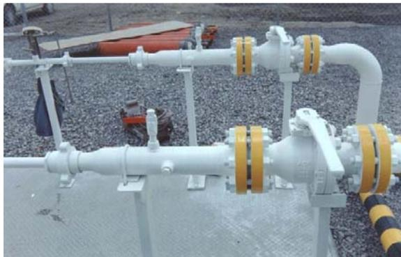
Las válvulas estarán dimensionadas y al libraje requerido por ANSI para la capacidad y la presión de diseño del sistema. Las válvulas bridadas deberán ser fijadas con espárragos ASTM, A-193 GR87 Clase 2A, y material de empaque de flexitalic de 1/16" de espesor.
