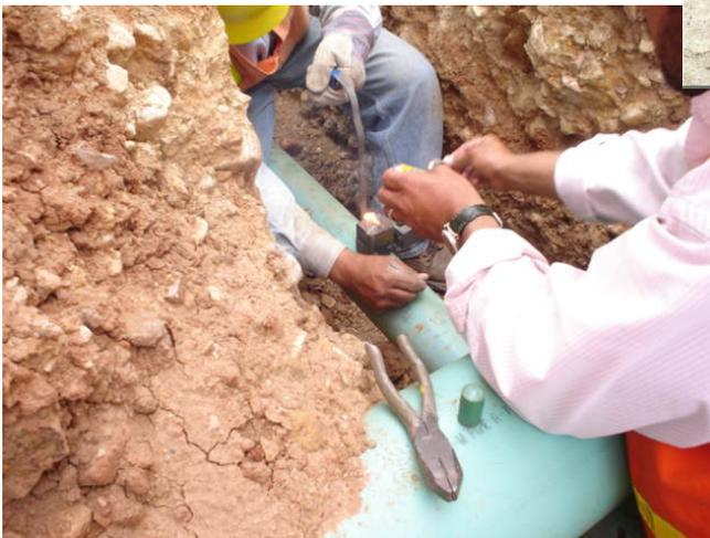
Se instalarán ánodos de magnesio preempacados de 9 libras para proteger toda la tubería de acero que queda subterránea, desde el punto de interconexión hasta el predio de los usuarios. De igual forma, se instalará un ánodo de magnesio de sacrificio de 9 libras en la caseta de medición en el punto de interconexión con el ducto de MAYAKÁN y en la caseta del usuario
