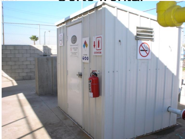
**Casetas de medición/regulación del usuario** (ver ejemplos de caseta típica de usuario, Plano No. 2 Sistema para regulación y medición tipo de la empresa contratante) instalada en la planta industrial de **Galletas Dondé**, donde tendrá lugar la segunda reducción de presión del sistema, de **100 psi a 30 psi** o a la que requiera el usuario. El tipo de caseta a instalar, dependerá de los requerimientos de volumen del usuario, pero sus características se pueden resumir de la siguiente manera:
