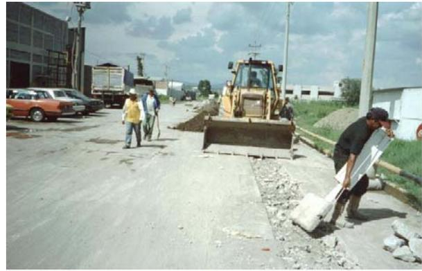
El relleno de la zanja y nivelado del Derecho de Vía deberán hacerse de tal manera que se restablezca el contorno natural del terreno y que permita el drenaje normal de la superficie.
