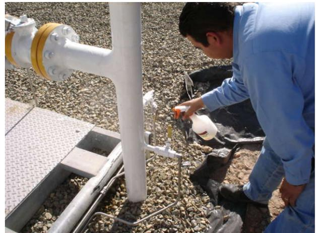
Se verifica la existencia de fugas en toda la estación de medición y regulación
