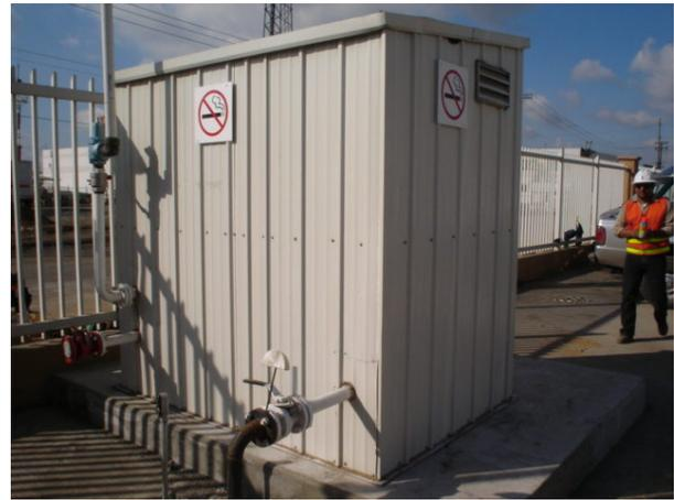
Se pintará toda la tubería aérea de acero de los patines de medición y regulación (a instalar dentro de los predios de los usuarios) de color blanco y amarillo limón. La pintura a aplicar para proteger contra la corrosión exterior cumplirá con las especificaciones de la **NOM-007-SECRE-1999**.
