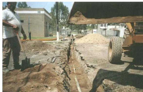
En zonas urbanas, la primera capa se compactará al 90% proctor, 25 pasadas con compactador bailarina 140 HP. Las capas subsiguientes se compactarán al 95% proctor con compactador bailarina 140 HP 35 pasadas. Se
