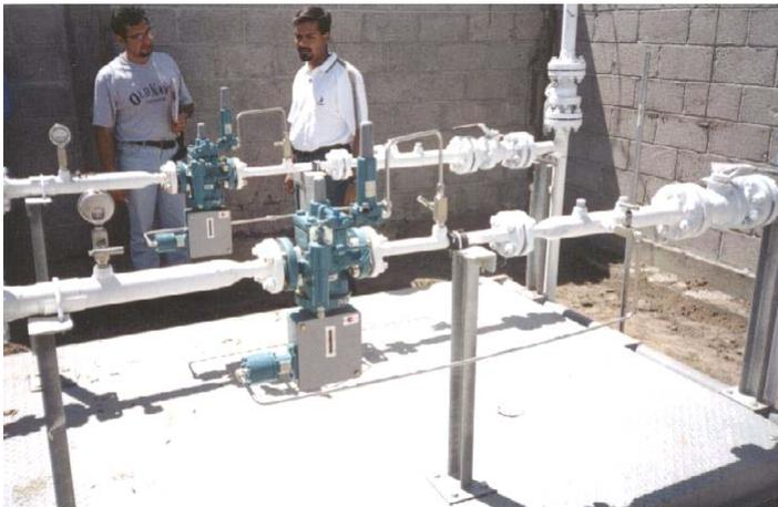
Se instalará un regulador de respaldo al regulador primario para facilitar el mantenimiento sin interrupción del sistema. En el punto de interconexión se contará con una válvula Slam-Shut de corte automático en caso de una caída de presión anormal en el sistema.
