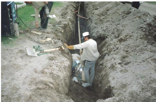
El gasoducto irá enterrado a todo lo largo del trayecto, salvo en los puntos de recepción y entrega. La excavación de la zanja permitirá que el ducto quede a una profundidad mínima de 1.30 metros, para cumplir una profundidad de cubierta mínima de **1 metro**.
