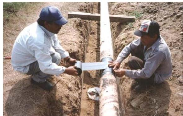
Para el control de corrosión externa, la tubería estará recubierta con un recubrimiento epóxico de acuerdo a lo establecido en los estándares de la Asociación Nacional de Aplicadores de Recubrimientos de Tubería (National Associated of Pipe Coating Applicators) y será realizado en planta del fabricante.
