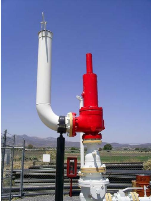
Las válvulas de protección por sobre presión (válvulas de alivio) han sido dimensionadas con capacidad suficiente para prevenir sobre presión de un sistema o segmento de sistema.
