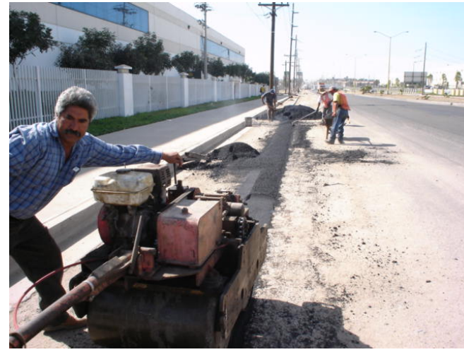
Aplicación y aplanado de asfalto
