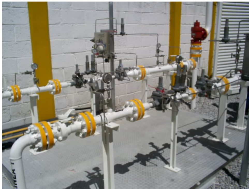
Ejemplo de una caseta de medición y regulación del punto de interconexión
