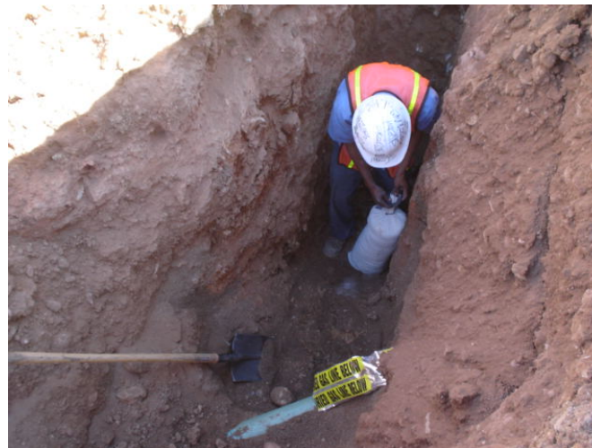
Colocación de ánodo de sacrificio de 32#
