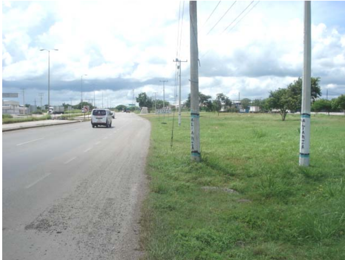
Vista de la Carretera No. 180 Mérida-Umán desde el punto donde doblará hacia la empresa Galletas Dondé.
