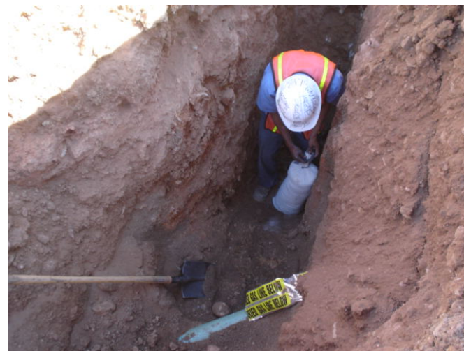
Colocación de ánodo de sacrificio de 32#
