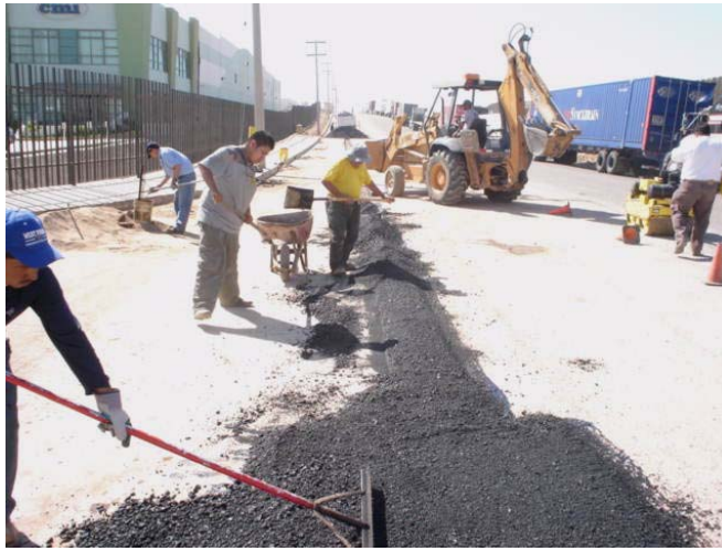
Aplicación y aplanado de asfalto
