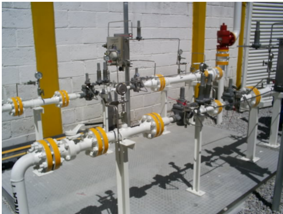
Ejemplo de una caseta de medición y regulación del punto de interconexión
