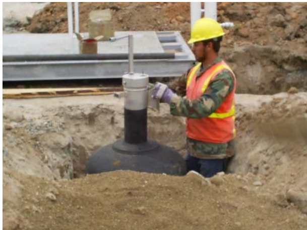
Instalación del tanque de odorización
