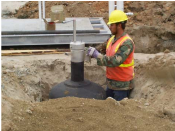
Instalación del tanque de odorización
