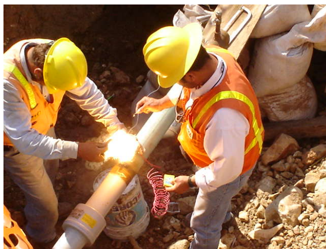
Colocación de ánodo de sacrificio de 32#
