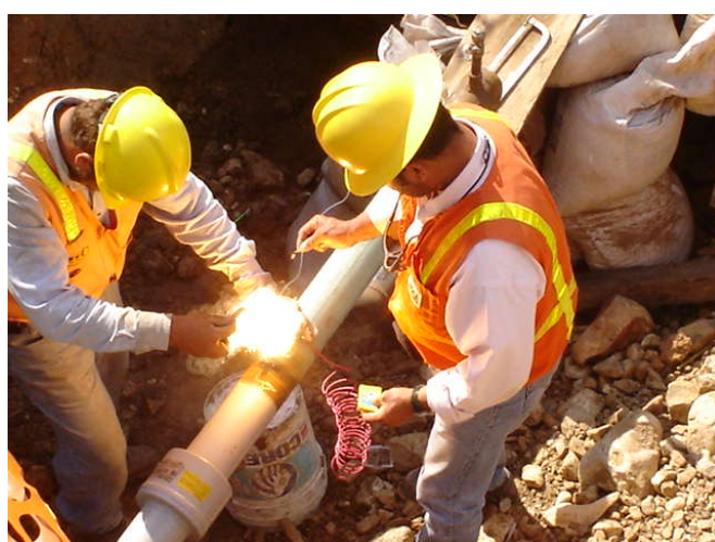
Colocación de ánodo de sacrificio de 32#
