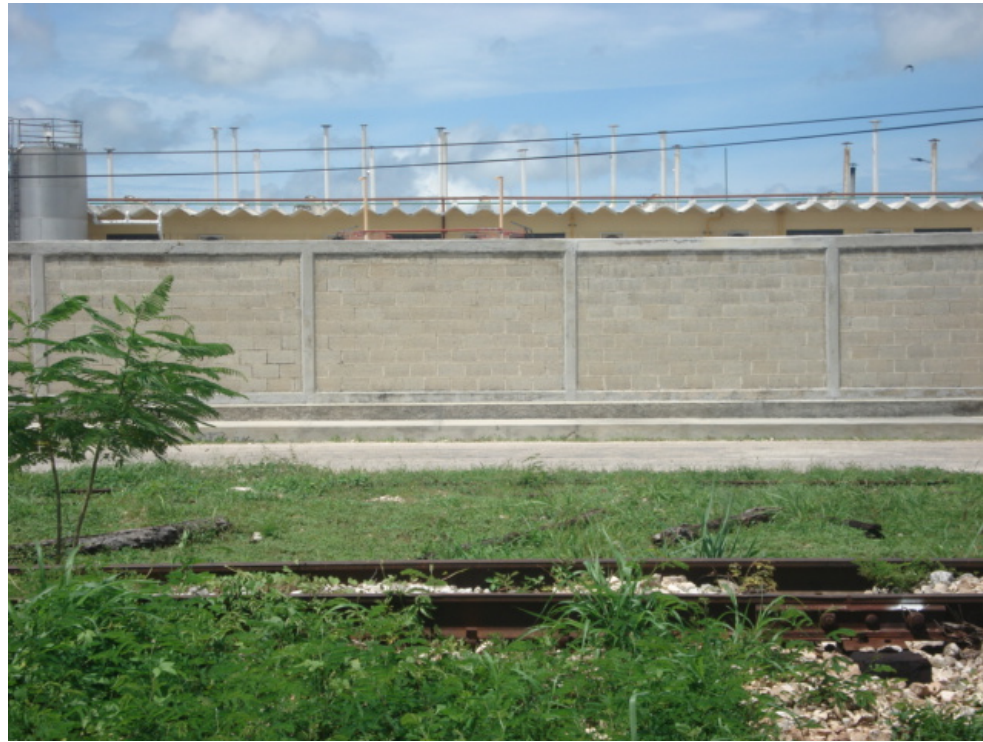
Vista frontal de la planta de Galletas Dondé, por donde entrará el ducto a la planta
