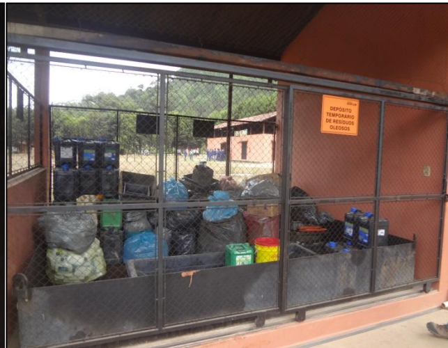
Foto 02 – Galpão onde são armazenados temporariamente os resíduos sólidos/líquidos oleosos do empreendimento – Fazenda Mãe D'Água.
