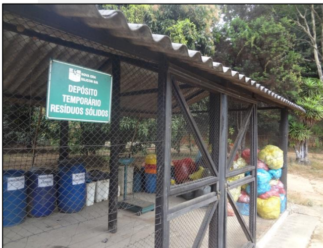
Foto 03 – Galpão onde são armazenados temporariamente os resíduos sólidos comuns do empreendimento – Fazenda Mãe D'Água.
