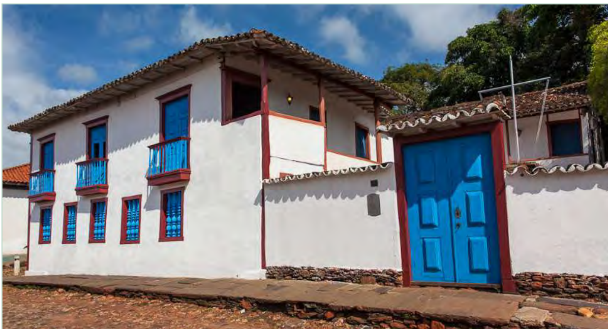
Figura 5.7 Vista do Museu de Ouro – Casa da Intendência.
