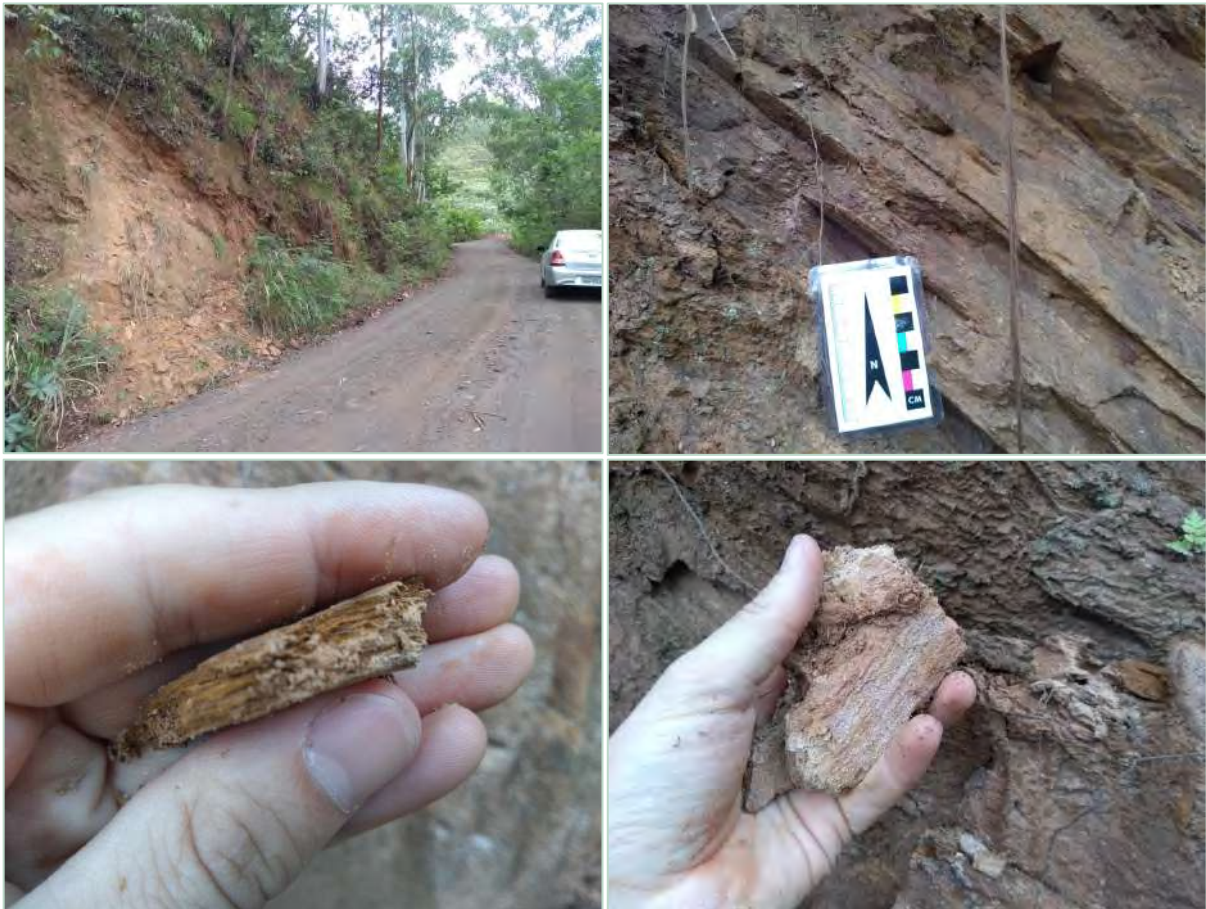
Figura 3.16 Rochas friáveis da unidade Córrego do Sitio registradas no Ponto MF04.
