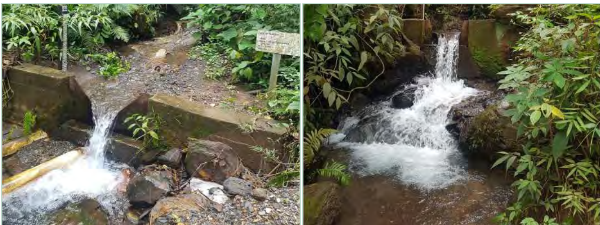
Figura 3.42 Vertedouros nas nascentes dos cursos-d'água afluentes da margem direita do ribeirão Sabará no interior da área de estudo.
