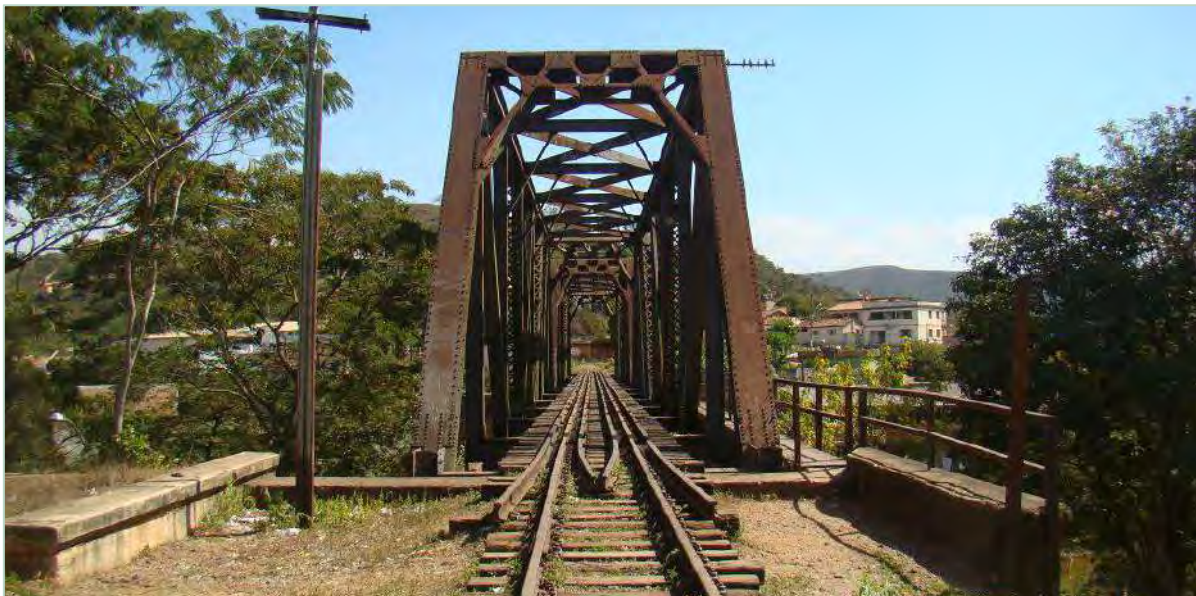
Figura 5.8 Vista da Ponte Ferroviária/Pontilhão.
