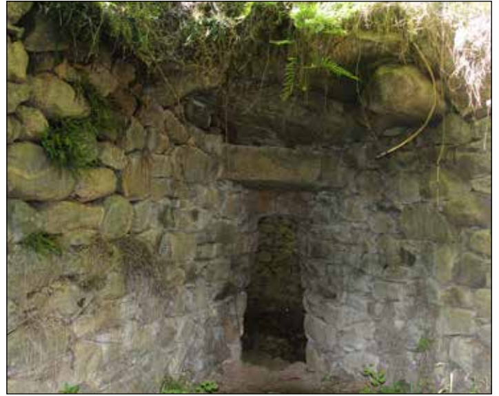
Fig. 2 : Ouverture de la tour.
