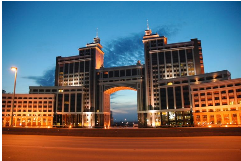
Edificio principal de la compañía KazMunayGaz (compañía petrolera de Kazak); http://en.wikipedia.org/wiki/Kazakhstan . Consulta: 9 de abril de 2011.
