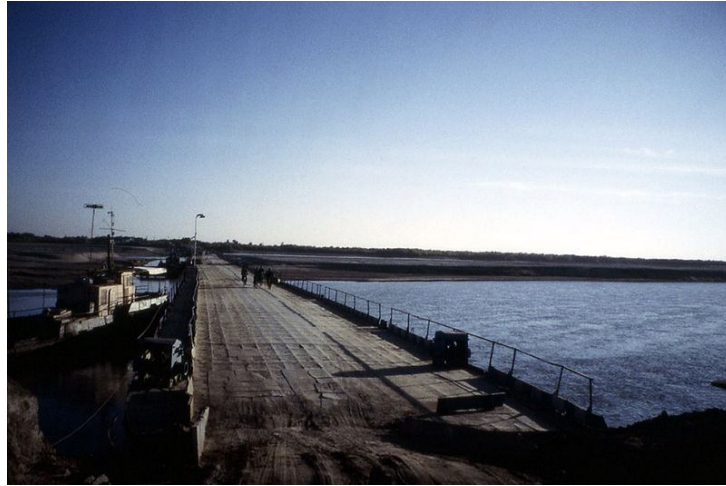
Puente sobre el río Amu-Darya en la ciudad de Urganj, Uzbekistán; http://en.wikipedia.org/wiki/File:Bridge.Amu.Darya.Urganj.jpg . Consulta: 3 de abril de 2011.
