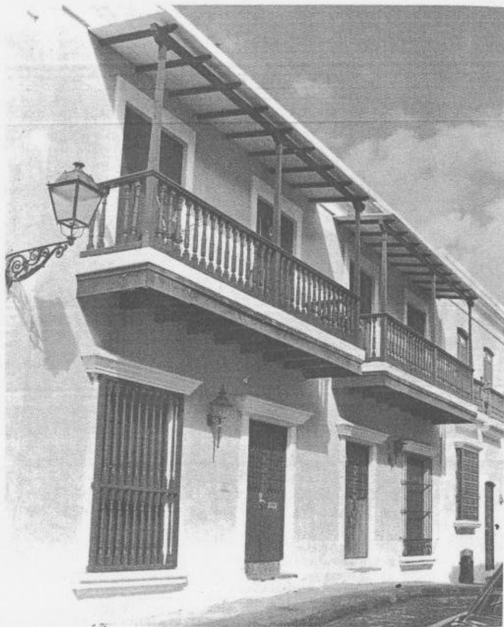
Núm. 86 Casa cuyo balcón tiene balaustres que ocupan toda la altura del antepecho. Calle de San Justo 6. Foto de la autora.
