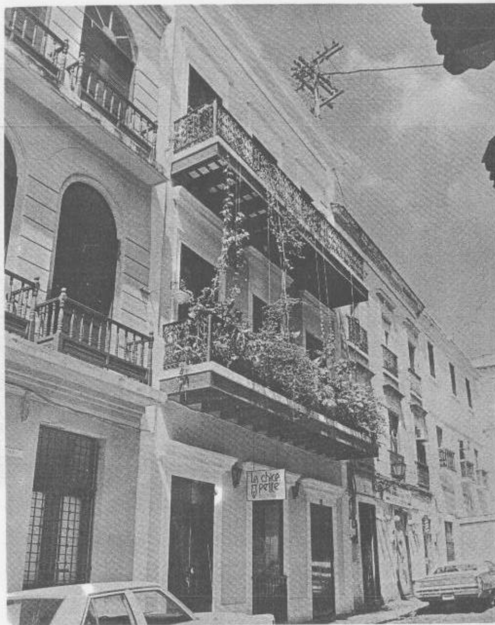
Núm. 83 Casa con balcones corridos y sin tejadillo. Calle de la Cruz 152. Foto de la autora.
