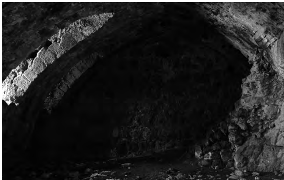
Fig. 8 – Vista della galleria interna del palazzo situato alle pendici di Montfort. La Galleria si struttura in appoggio a una parete scavata nella roccia viva, debitamente modellata per accogliere delle condutture d'acqua provenienti dal traverso idraulico esterno. Tale conformazione ben si adatta all'inserimento di ruote verticali.
