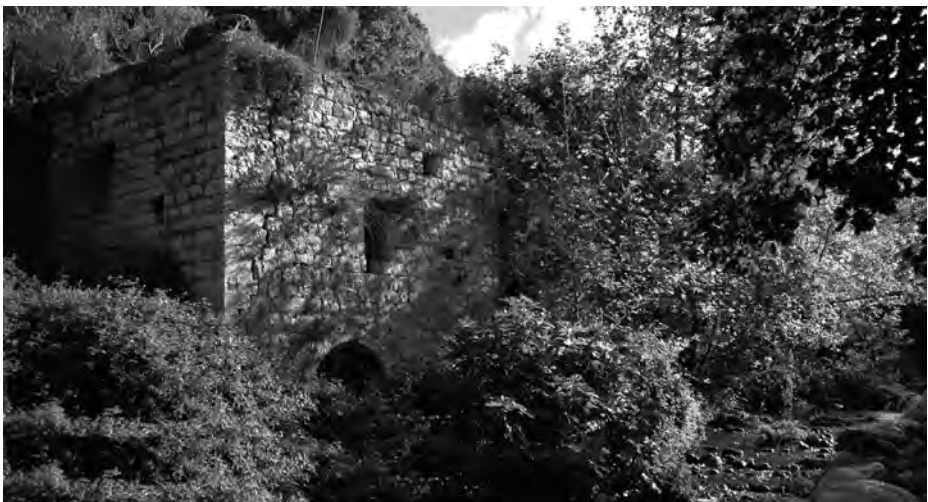
Fig. 7 – Resti di una struttura molitoria sita sul versante del fiume Achzive.
