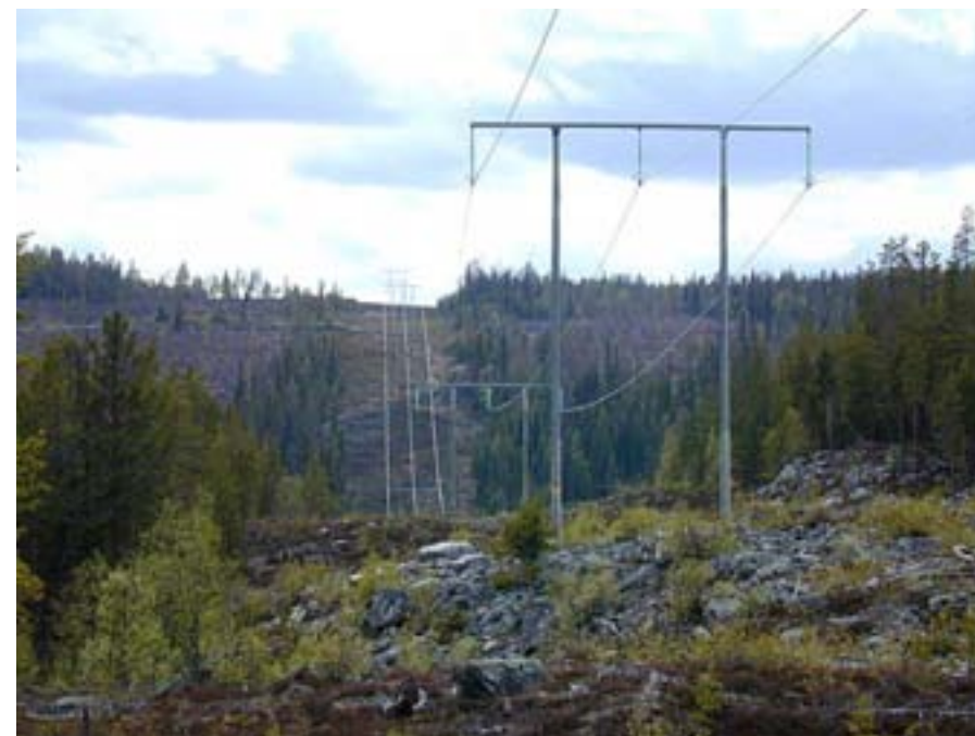
220 kV ledning från Långå kraftverk till Rätan
