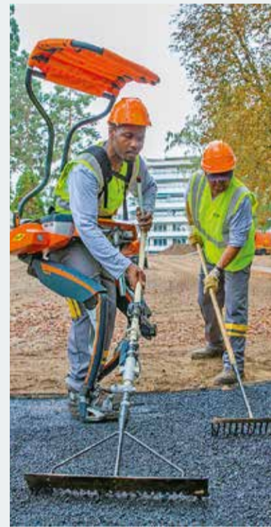
RB3D et la filiale Suisse de Colas ont adapté l'exosquelette Hercule aux besoins des ouvriers travaillant sur les routes.
