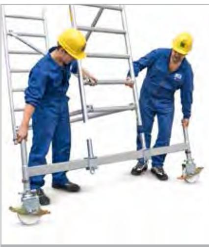
Aufsteckrahmen auf die Fahrbalken aufsetzen ...
