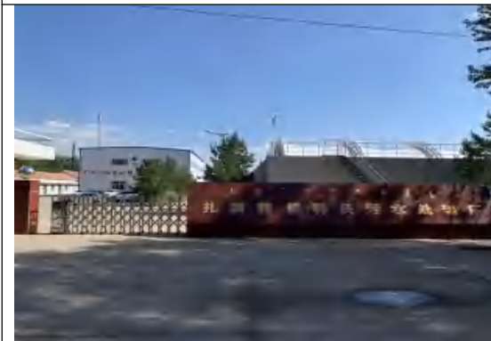
扎赉特旗利民污水处理厂
