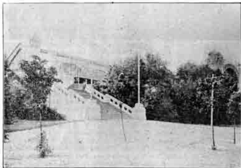
Schodiště pod strojovnou.
