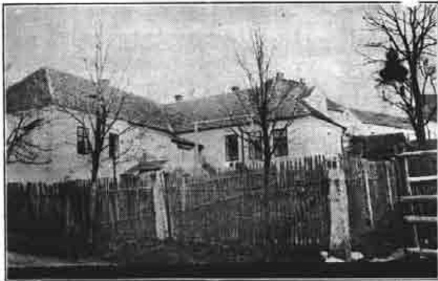
Školní budova v Lašovicích, kde působil Aug. Gerlinger.
