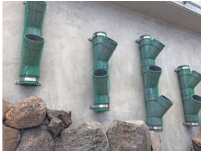
図45 整備中 塩ビ管を取り付けた壁。
