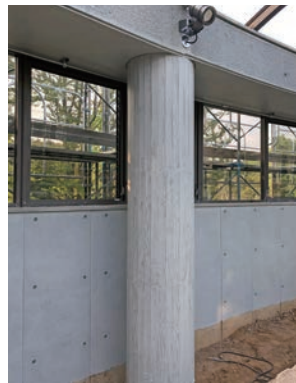
図13 作業後 浮造りを施した柱。
