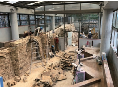
図24 石積み作業中 人力で積み上げる作業中。
