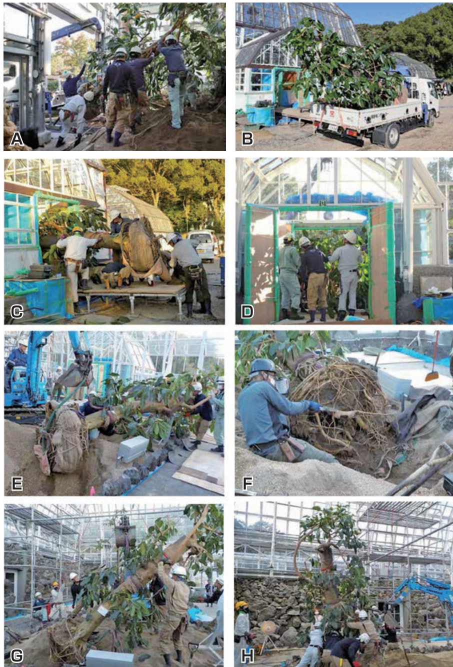
図13 インドゴムノキの移植 A：保管温室空扉の高さギリギリで吊りだし。B：温室前へ到着。C：台車で的人力運び込み。D：扉に当たらないよう細心の注意で引き込み。E：小型重機による前館内移動。F：根鉢の状況。G：タワーに掛けたロープで立て起こし。H：向きと角度を調整。
