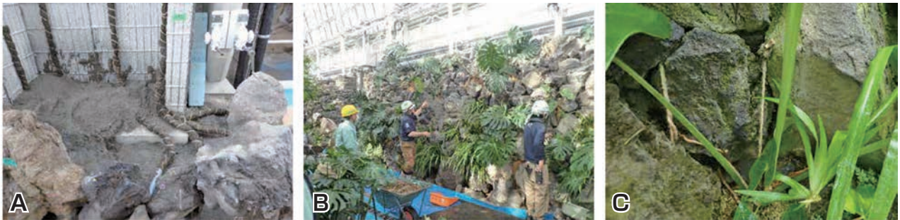
図17 中央ヤシ室岩組への植栽 A:裏込めコンクリート内のココヤシロープ。B:水苔を岩の隙間に押し込み植付け。C:竹串と麻縄で固定。
