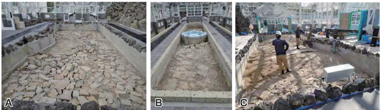
図11 客土投入 A: 中央ヤシ室植栽枠切石層。B: 東花卉室切石層。C: ベルトコンベアによる客土投入の様子。
