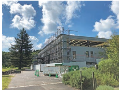
図16 再整備中の外観 足場が設置された温室。
