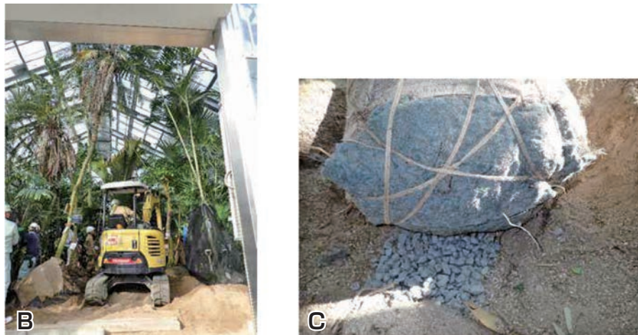
図10 移植作業 A: 保管温室配置図と移植順序。B: ヤシの間からインドボダイジュを引き出す。C: 透水シートごと上げ巻きした根鉢。
