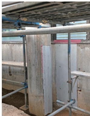
図12 浮造り施工 作業前後のシュミレーション。
