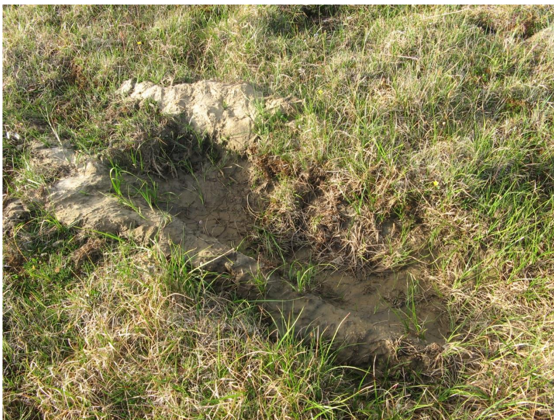
Фото 7.33. Небольшие повреждения на фоне неглубоких колея © С.В.Чиненко
