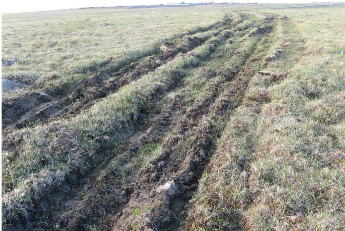
Фото 7.37. Глубокая колея, отходящая от нарушенного участка II (Мккк9) в сторону автомобильной дороги от точки Мккк9-0 © С.В.Чиненко
