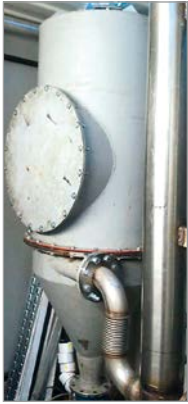
8. ábra Füstgáz hőcserélő szigetelés előtt
