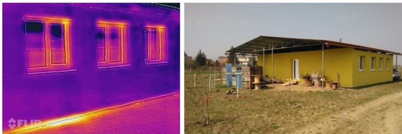
Obr. i3: Vľavo – termovízia vonkajšieho plášťa, vpravo – finálna podoba rekonštrukcie, juho-východný pohľad na dom (možno vidieť aj 3 orechy zasadené z južnej strany – označené bielymi kolíkmi)
