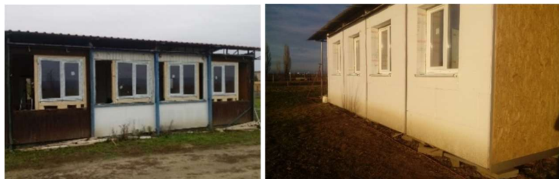
Obr. i2: Vľavo – výmena okien, vpravo – zateplenie plášťa domu
