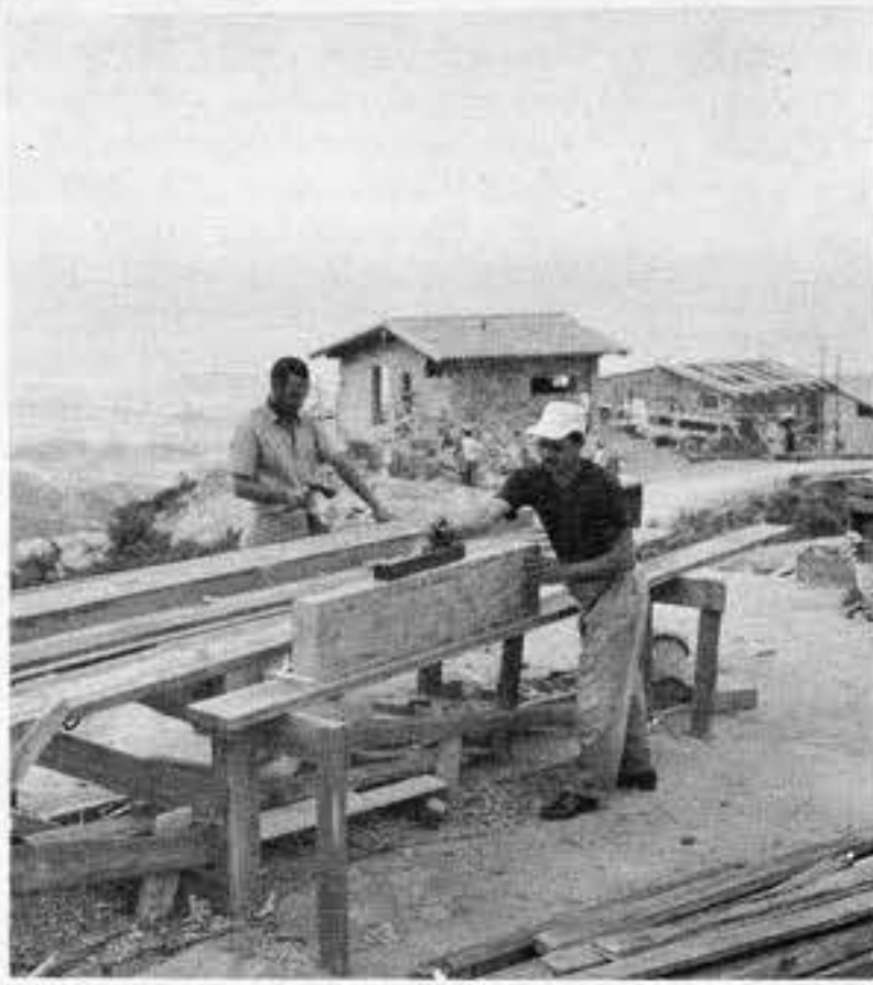
UNA RECONSTRUCCION DE LAS ANTIGUAS CABALLERIZAS PERTENECIENTES A LOS CAFETALES FRANCESES
