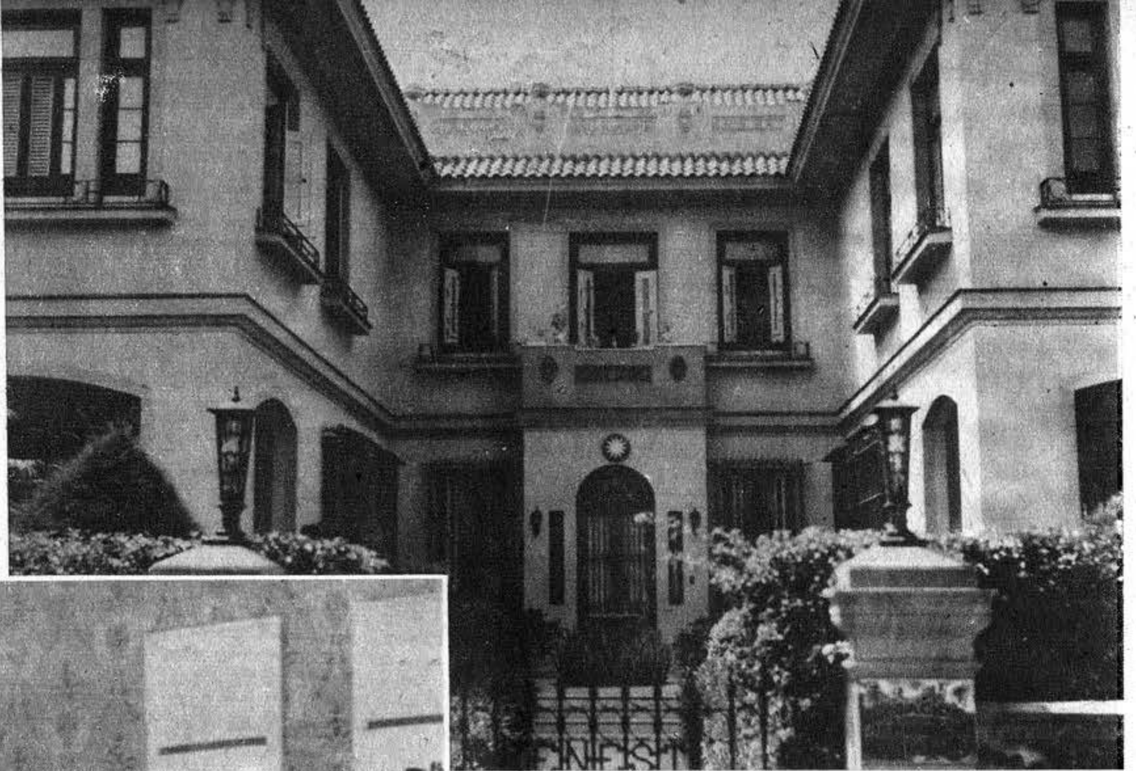
Una vista exterior del magnífico y hermoso edificio que ocupa la Legación China en el reparto Miramar.
