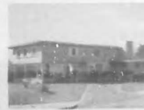
...en ladrillo, concreto y mampostería en general...
