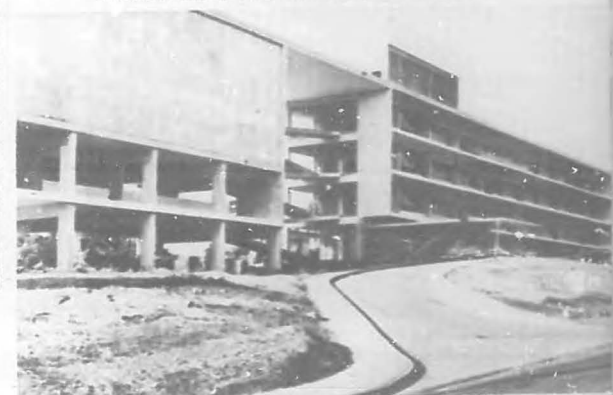
El nuevo y modernísimo edificio Central de la Universidad de Oriente, levantado a un costo de casi un millón de pesos y que pronto quedará totalmente terminado. Consta de cuatro plantas y alberga, entre otras dependencias, las siguientes: Oficinas de Secretaría y Tesorería, Teatro Universitario, Cafetería y Aulas. Es, desde ahora, una de las unidades de la Ciudad Universitaria.
