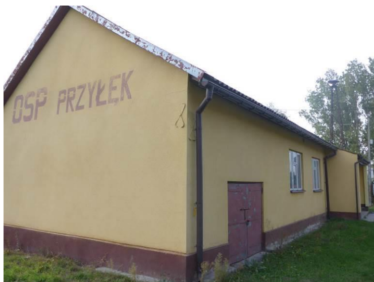
Zdjęcie 64 Budynek Ochotniczej Straży Pożarnej w Przyłoku. Fot. GRACZKOWSKI DOTACJE Sp. z o.o., październik 2015.
