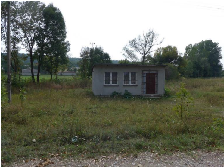
Zdjęcie 87 Budynek świetlicy wiejskiej w Woli Lubeckiej. Fot. GRACZKOWSKI DOTACJE Sp. z o.o., wrzesień 2015r.
