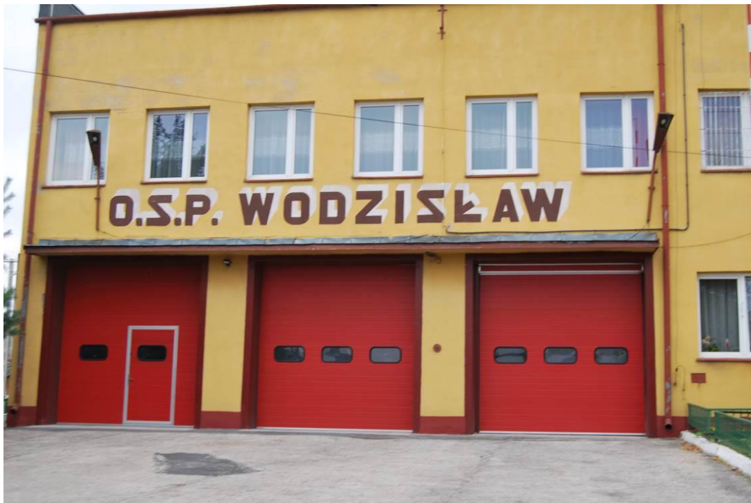
Zdjęcie 86 Budynek remizy Ochotniczej Straży Pożarnej w Wodzisławiu. Fot. GRACZKOWSKI DOTACJE Sp. z o.o., sierpień 2015r.
