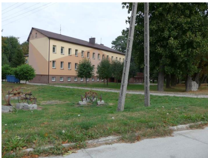
Zdjęcie 70. Blok mieszkalny w Przewodach. Fot. GRACZKOWSKI DOTACJE Sp. z o.o., wrzesień 2015r.
