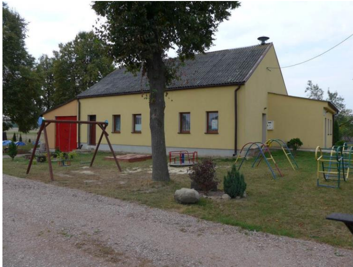
Zdjęcie 69. Remiza Ochotniczej Straży Pożarnej i świetlica wiejska w Przewodach. Fot. GRACZKOWSKI DOTACJE Sp. z o.o., wrzesień 2015r.
