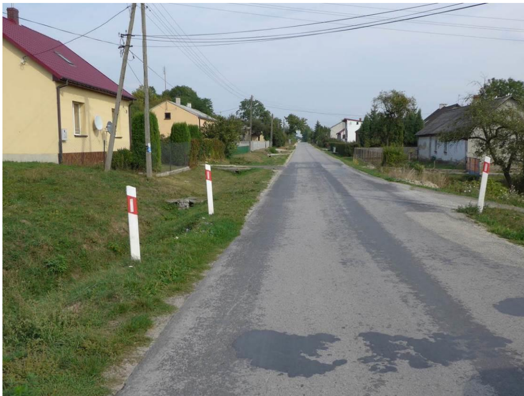
Zdjęcie 38. Droga w miejscowości Laskowa. Fot. GRACZKOWSKI DOTACJE Sp. z o.o., wrzesień 2015r.
