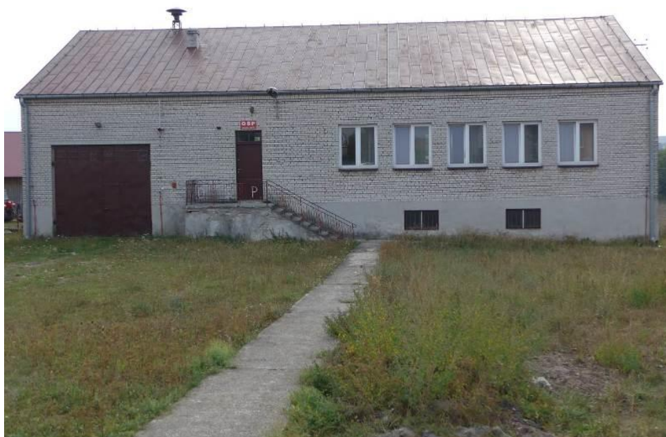
Zdjęcie 48. Budynek remizy OSP w Niegosławicach. Fot. GRACZKOWSKI DOTACJE Sp. z o.o., wrzesień 2015r.
