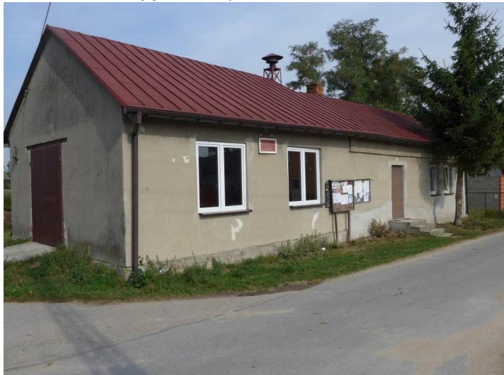
Zdjęcie 56. Budynek Ochotniczej Straży Pożarnej w Pokrzywnicy. Fot. GRACZKOWSKI DOTACJE Sp. z o.o., wrzesień 2015r.
