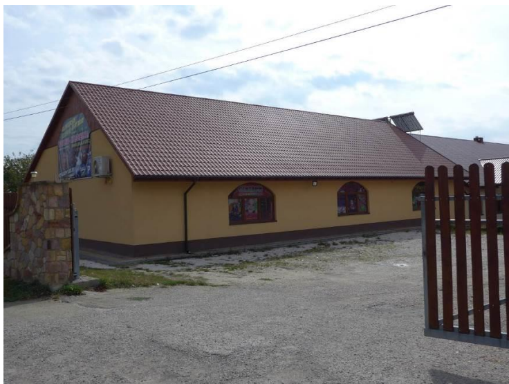
Zdjęcie 24. Centrum rozrywki w Kowalowie Dolnym (dyskoteka, restauracja). Fot. GRACZKOWSKI DOTACJE Sp. z o.o., wrzesień 2015r.
