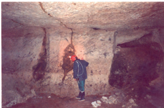
Figure 1 : Galeries du primokarst recoupées par la carrière souterraine de La Mansonnière.
