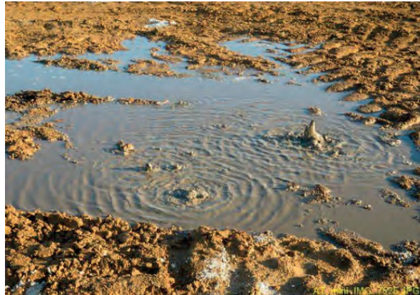
Figure 6 : Remontées de l'air injecté en cours de forage.
