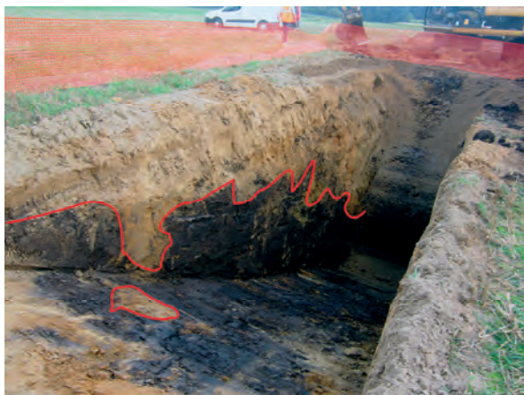
Figure 3 : Fouille de reconnaissance du sol meuble de teinte noire lors de travaux de terrassement à Péruwelz.
