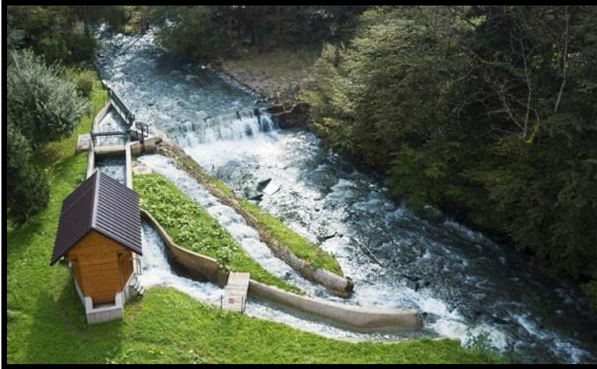
Slika 20: MHE Ruše (vir: http://www.dem.si/sl-si/Elektrarne-in-proizvodnja/Elektrarne/Mala-HE-Ruše )
