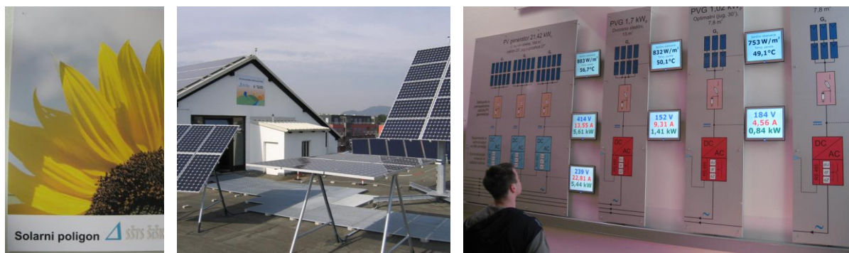
Slika 15: Omrežna sončna elektrarna na strehi šole in šolski monitoring za diagnostiko delovanja.
