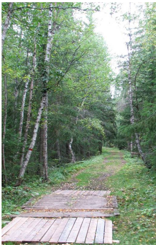
Alla provisoriska broar bör bytas ut!
