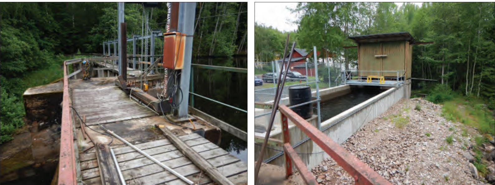
Figur 8. Dammanläggningen vid Kyrkekvarn vid Stråkens utlopp. Foto: Länsstyrelsen i Västra Götaland.
