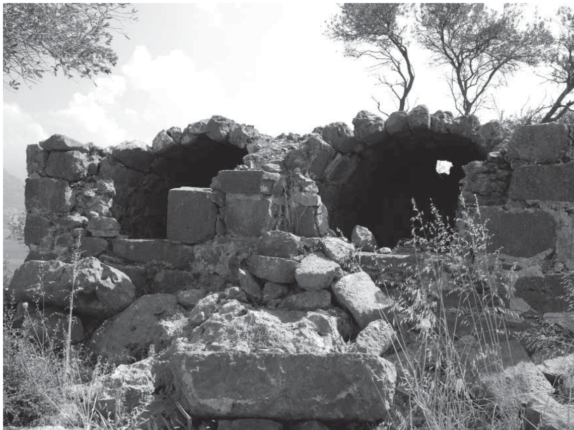
Foto 16. Ka6, tomba a camera doppia. Prospetto sud-ovest.
