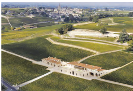
Vue du Château Pavie et ses nouveaux chais
