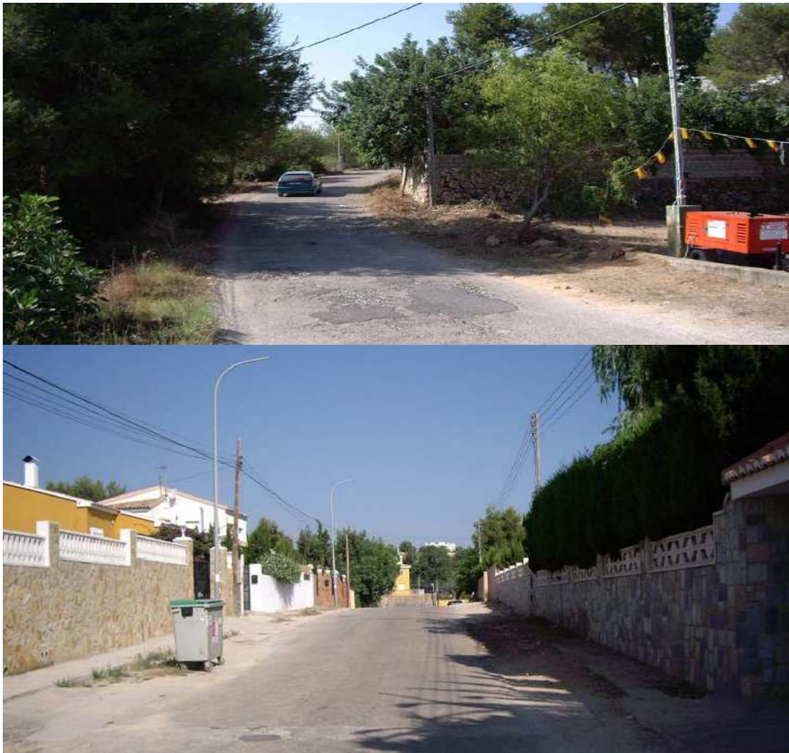
Imagen del estado general del asfaltado, red eléctrica y alumbrado público en la urbanización "Los Lagos".
