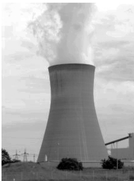
Figura 5.14: Torre de enfriamiento de una central térmica 23
