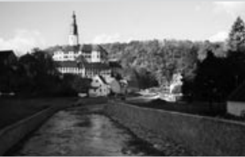
Wenige Jahre nach dem Hochwasser ist die Müglitz auf weiten Strecken wieder eingemauert – bis zum nächsten Mal?
