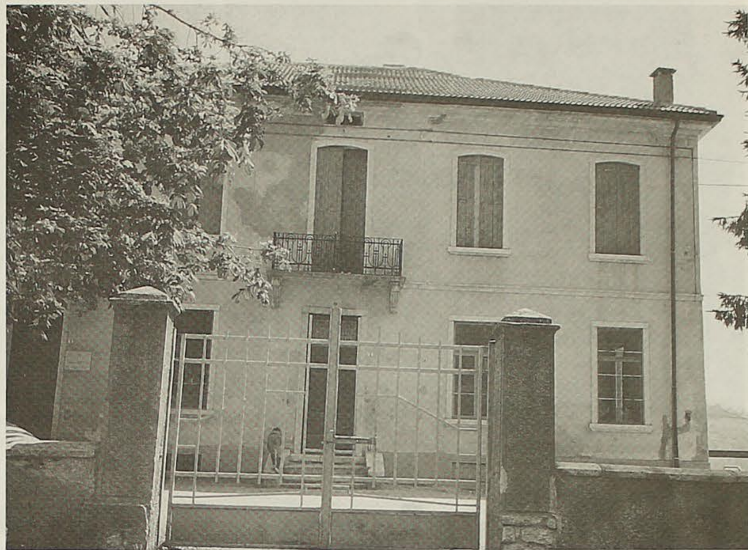
Le scuole elementari di Conco prima dei lavori di sistemazione, quando il riscaldamento funzionava meglio di oggi.
