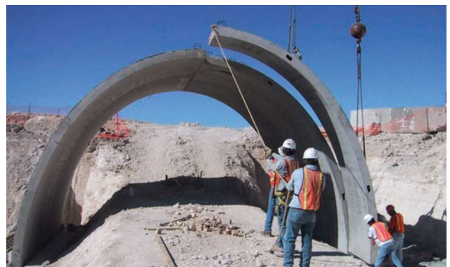
Figura 1 – Montagem dos elementos de arco pré-fabricados. Retirado de BEBO Arch International AG (2011) e Terre Armée Group (2018).
