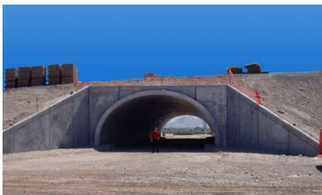
Figura 2 – Exemplo de aterros executados. Retirado de BEBO Arch International AG (2011).
