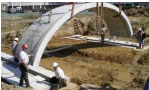
Figura 1 – Montagem dos elementos de arco pré-fabricados. Retirado de BEBO Arch International AG (2011) e Terre Armée Group (2018).
