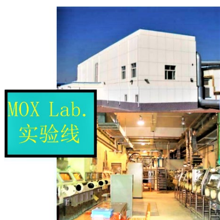
図12 MOX 燃料製造試験施設
