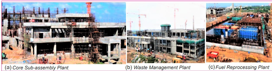
図17 FRFCF の建設状況(2019 年)
