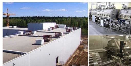
図6 建設が進む PDEC の燃料製造施設
