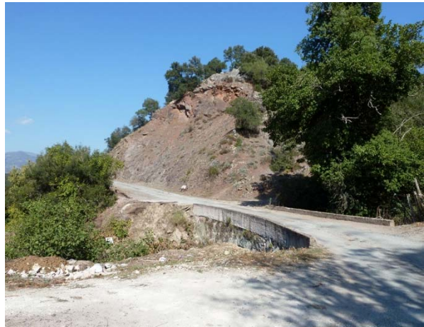
Talus en bordure de route (photos DG)
