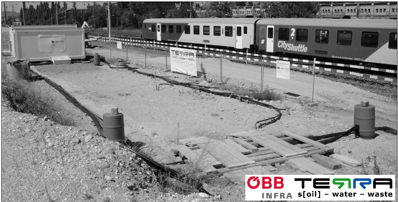
Abb. 1: Ansicht Sanierungsfeld HBf Wien
