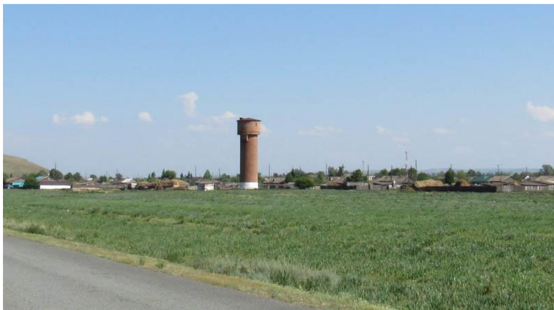
Рис. 17. Водозаборная скважина с водонапорной башней на северо-западной окраине с. Кавказское (фото Степанов Н.В.)
