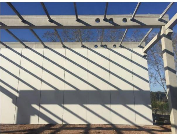
**Viga rectangular:** Son jácenas tanto de hormigón armado como pretensado, de sección rectangular y canto constante, con anchuras desde 50 cm y canto variable hasta 110 cm. Su aplicación principal es la de servir de apoyo a forjados de placas alveolares.
