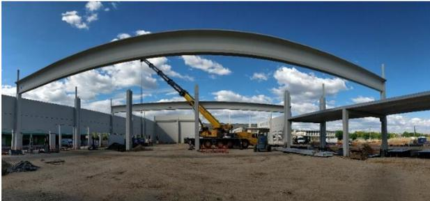
**Viga en “y”:** conocida también como “ypsilon” (i griega), es una viga de gran canto (entre 1 y 1,75 m aprox.) que se utiliza principalmente como elemento soporte de la cubierta, por su mayor estabilidad y la gran capacidad de evacuación de aguas pluviales, pudiendo
