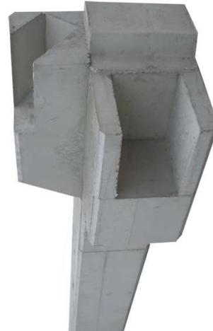
Una variante interesante de pilares es aquella en que en cada línea de forjado se deja una reserva exenta de hormigón pero con toda la armadura a la vista, con objeto de rigidizar posteriormente el nudo con hormigón puesto en obra. Esta solución permite resolver de forma hiperestática la unión, así como lograr alturas mayores de pilares.
