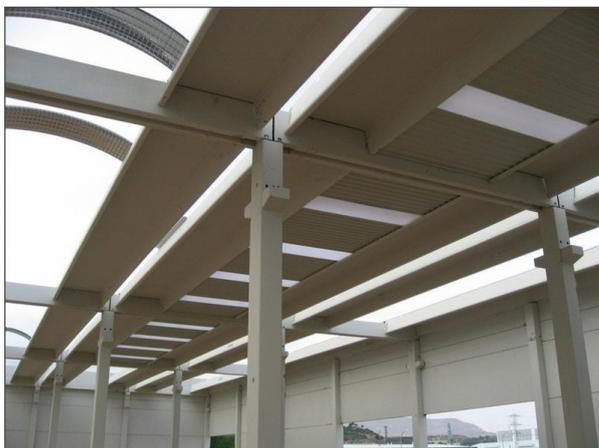
**Viga "omega":** su geometría consigue aportar la recogida de las aguas pluviales, así como conformar por si misma gran parte de la cubierta del edificio, con la que se alcanzan luces máximas de 25 m. Puede incorporar de fábrica la chapa de cubrición y el aislamiento, proporcionando así una solución completa
