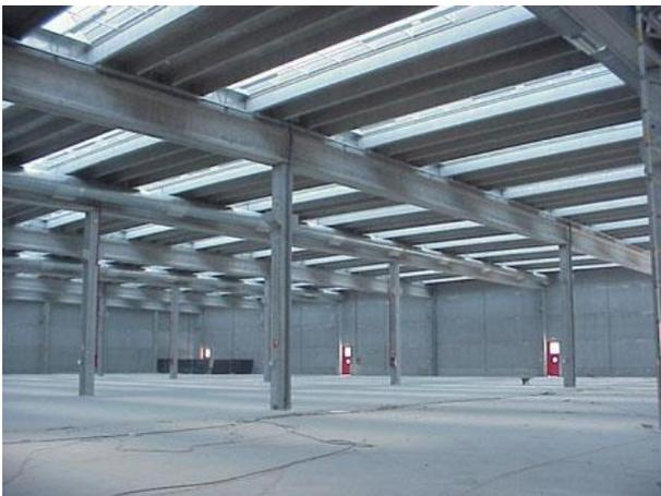
**Vigas en I:** También conocidas como doble T, se trata de elementos generalmente de hormigón pretensado, aunque también pueden estar armadas. Tienen sección constante, pudiendo incorporar macizados en sus apoyos en función de las solicitudes de proyecto. Longitud aproximada hasta 45 m. Uso principal como elemento de apoyo de vigas o correas de cubierta.
