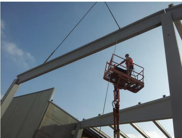
**Vigas T:** Vigas pretensadas o armadas con posibilidad de distintas secciones, aunque constantes a lo largo de su longitud, para utilización en pórticos hastiales (vigas piñón), entreplantas de forjado, cubiertas con placa alveolar, carrileras para puente grúa, etc.
