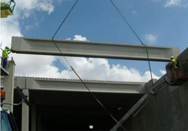
**Vigas en DT:** Variante de la sección anterior, con la diferencia de que en los extremos se ensancha siendo de sección rectangular. Usos principales como jácena de apoyo de elementos de forjado (placas alveolares), viga carril de puentes grúa, etc.
