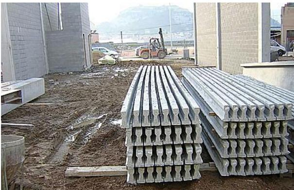
**Sección vigueta:** Este tipo de correas tienen las mismas características que las viguetas utilizadas para los forjados. Pueden ser de hormigón armado o pretensado. En función de las cargas y las luces especificadas en el proyecto se utilizarán unas u otras.
