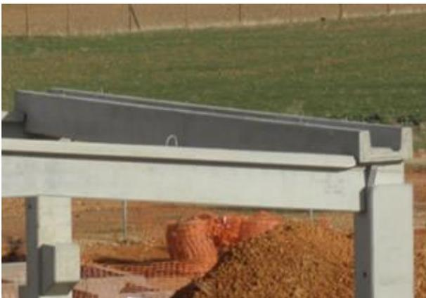
**Viga canal:** Este tipo de vigas tienen como función principal la recogida de las aguas de la cubierta, sirviendo también como soporte a los cerramientos prefabricados y dotando a la estructura de una mayor rigidez (arriostramiento en el sentido longitudinal de la estructura). Adicionalmente, esta pieza requiere de una impermeabilización exterior para garantizar el perfecto sellado y
