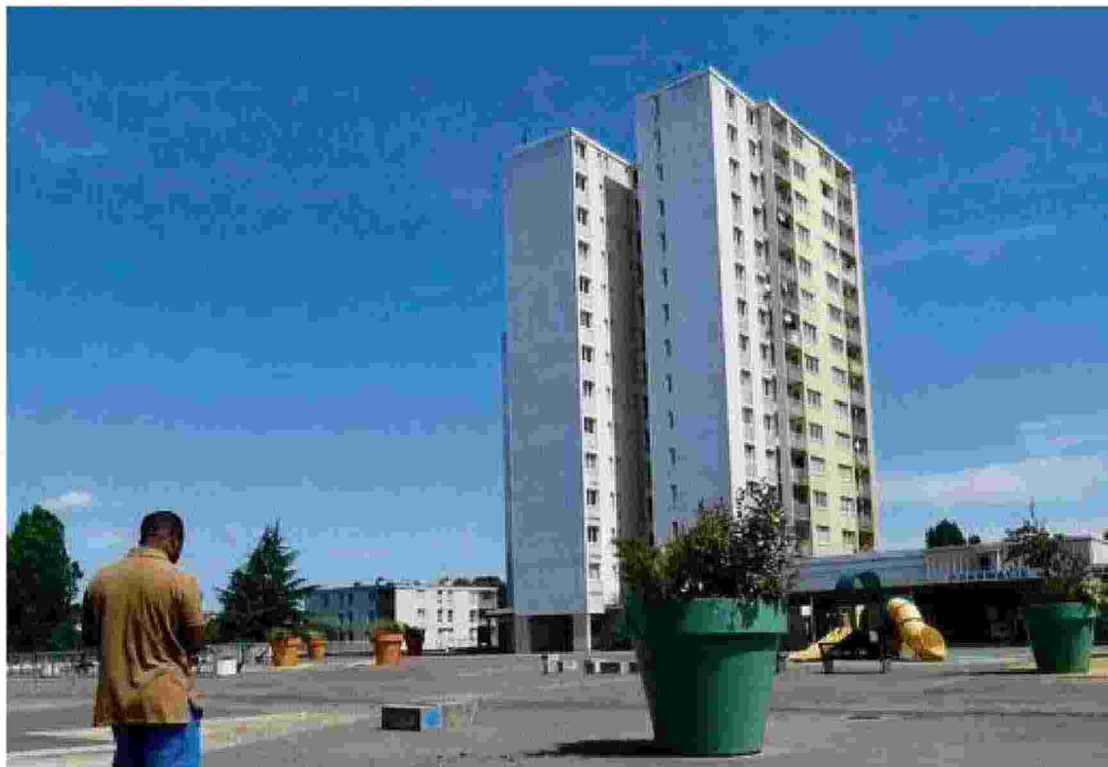
Le bâtiment 7 du quartier du Parc aux lièvres, à Evry (Essonne), le 6 juillet 2019. HERMINE LE CLECH/PHOTOPQR/LE PARISIEN/MAXPPP
