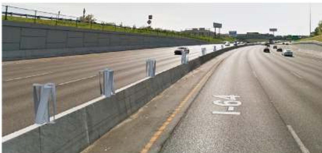
Figura 4.9. Model de turbine antrenate de curenții generați de circulația mașinilor (Sursa: ELSEVIER)
