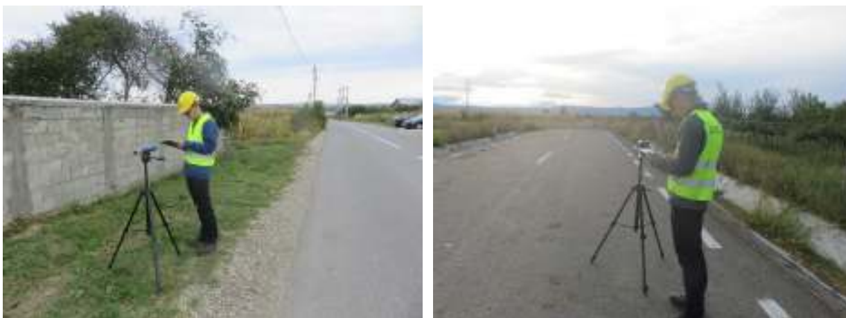
Foto 6.4. Măsurarea nivelului de zgomot
