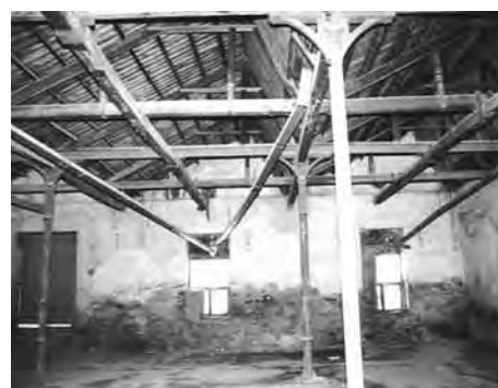
Εικ.10 Εσωτερική άποψη Κλωστοϋφαντουργίας Μουρτζούκου με ξύλινο φέροντα σκελετό στέγης και φέρουσα λιθοδομή
