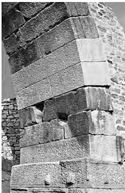
Πίνακας 8. Αναστήλωση του μεγάλου τόξου αντιστήριξης του αρχαίου θεάτρου των Φιλίππων
