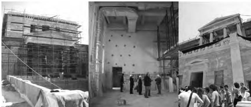
Εικ.3 Εκπαιδευτικές επισκέψεις σπουδαστών στο εργοτάξιο κατά την διάρκεια των εργασιών αποκατάστασης του κτηρίου Αβέρωφ.
