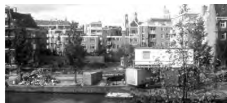
Εικ.5 Οικοδομική ασυνέχεια της οδού Nieuwe Herengracht
