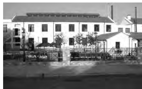
Εικ.4 Μεταξουργείο Ετμετζόγλου στο Βόλο, μετά την αποκατάσταση
