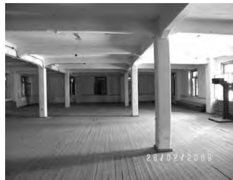
Εικ.12 Εσωτερική άποψη της Κίτρινης Αποθήκης με φέροντα οργανισμό από οπλισμένο σκυρόδεμα
