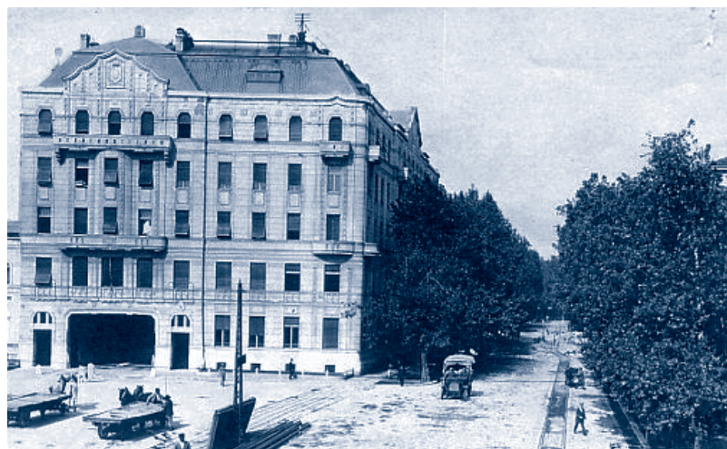
Palazzo delle Ferrovie, viale CCNN n. 1, Angolo Žabica Costruito nel 1911 in stile “secessione magiara”
