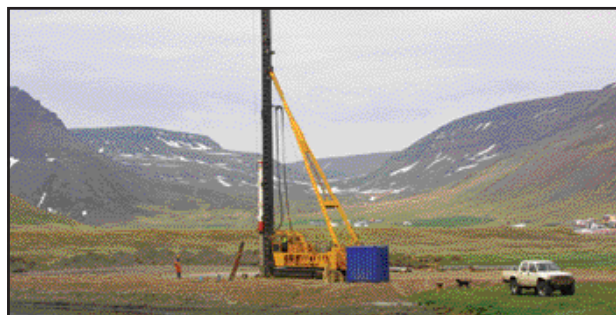
Frá Ósá við Bolungarvík er framkvæmdir hófust fyrir í sumar. blautt og erfitt, en að öðru leyti er allt í besta lagi“, segir Örnólfur. Gert er ráð fyrir því að umferð verði hleypt yfir hina nýju brú þann 15. september á næsta ári.
