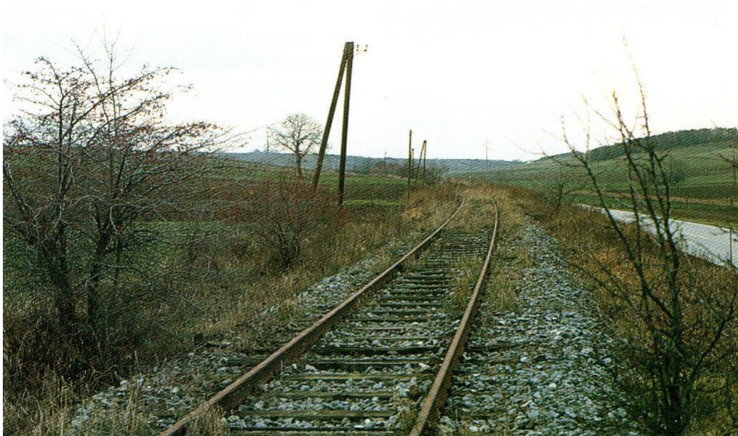
Abb. 5: Zustand der Bahnstrecke westlich von Kleinhadernsdorf im Jahr 1992. Gleise, Bahnschwellen sowie die Trassen begleitende Leitung sind noch vorhanden, ebenso ist beginnender Gehölzaufwuchs zu erkennen. / State of the railway line west of Kleinhadernsdorf in 1992. Tracks, sleepers and the cable along the railway line are still present; beginning growth of wooded vegetation is visible. Quelle: Berg & Zelz (1994).
