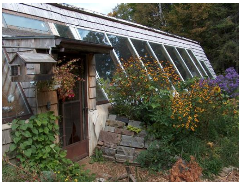
FIGURA 8 - Potter's house em Bancroft, Ontário-Canadá (exemplo de earthship). FONTE: www.sunspace.org/en/pottershousen.html
