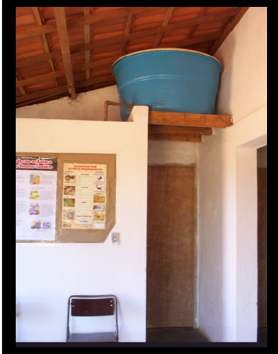
FIGURA 3 – Proj. Habitar Brasil Ilhéus/BA, interior casa. FONTE: Mônica Fittibaldi
