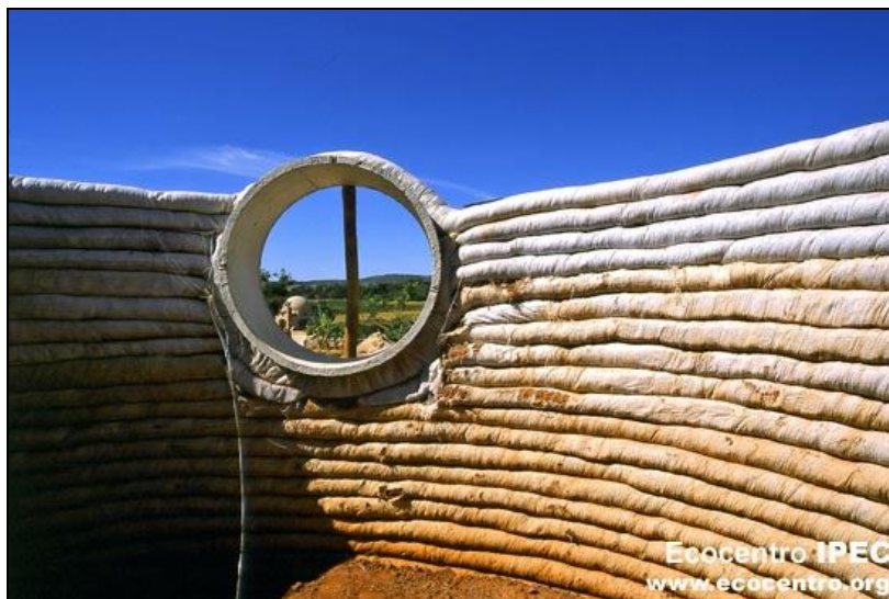
FIGURA 5 - Processo construtivo denominado super-adobe – técnica construtiva sustentável. Centro de Permacultura de Pirinópolis-GO.
