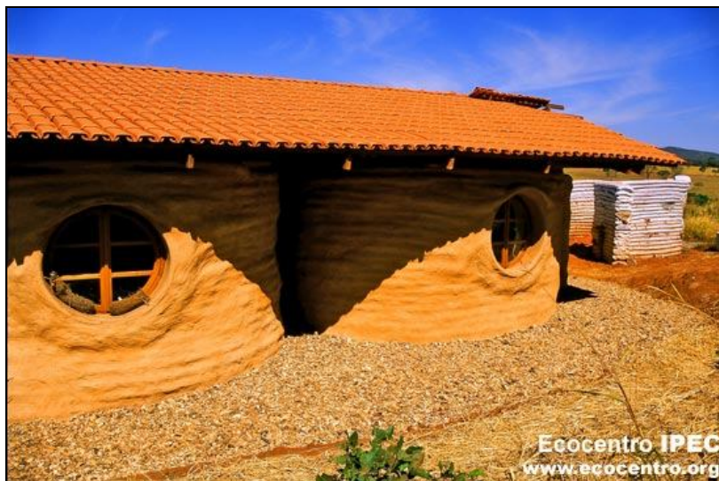
FIGURA 6 - Fachada de uma construção feita com a técnica do super-adobe. Alojamento para estudantes do Centro de Permacultura de Pirinópolis-GO. FONTE: IPEC.
