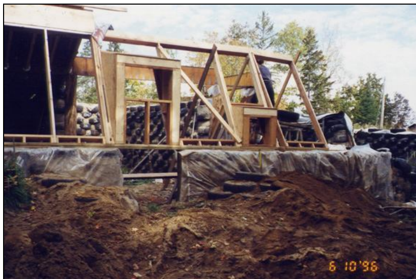
Figura 7 - Processo construtivo da Potter's house em Bancroft, Ontário-Canadá (exemplo de earthship). FONTE: www.sunspace.org/en/pottershhouse_en.html .
