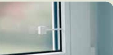
Passive Glasbruchmelder werden direkt an der zu sichernden Fensterfläche angebracht und werten Ultraschallsignale an der Scheibe hinsichtlich Frequenz und Amplitude aus. Die bei Glasbruch entstehenden Schwingungen werden sofort erkannt und ein Alarm wird ausgelöst.
