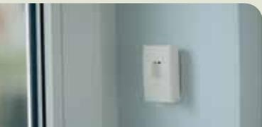
Akustische Melder werden meist gegenüber der Glasfläche angebracht. Sie analysieren akustische Frequenzen und erkennen die typischerweise bei Glasbruch auftretenden Geräusche und Druckwellen. Somit ist gewährleistet, dass keine alltäglichen „Klirrgeräusche“ einen Alarm verursachen.
